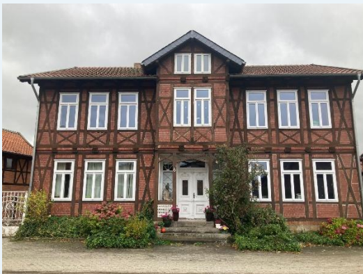
Abb 3 Beispiel für Bausubstanz von 1870 bis 1945
