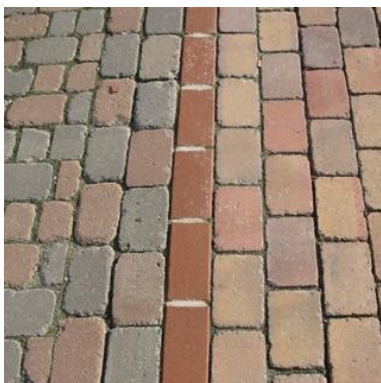
Abb 25 Gerumpeltes Betonrechteckpflaster, Naturstein/Klinker, Holz-Staketenzaun
