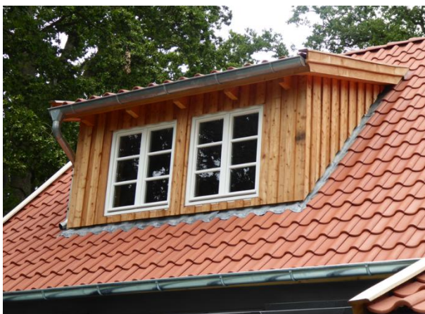
Abb 13 Beispiele: Dachgaube mit Holzverschalung, erneuerte Fachwerkfassade
